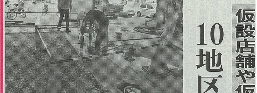
茨城県大洗町磯浜地区で「仮設事務所」が着工した(6月18日)
